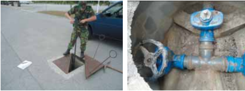
Figura 4 – Fechamento de válvulas
