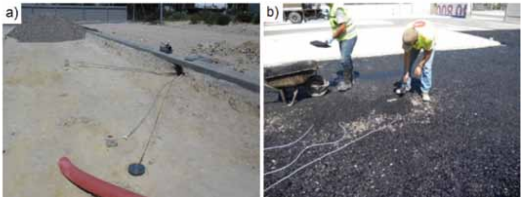
Figura 3 – Instrumentação da camada granular e da camada betuminosa das secções experimentais.
